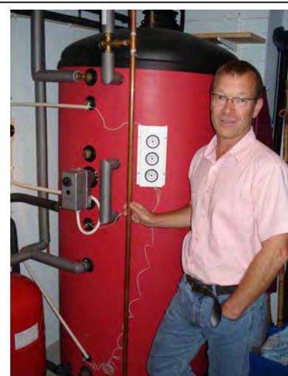
Solvärmes tanken på 750 liter är välisolerad med 90 mm PUR. – Jag ska isolera även detta kallvattenrör, säger Olle.
