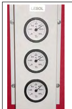
Den helsoliga dagen 7 aug blev tanken nära 90°C. Tre solfattiga dagar senare var det fortfarande nära 60°C i toppen och gott om varmvatten.
