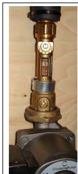
Ett flöde på 5 – 6 liter/min är lagom vid 10 m 2 solfångare.
